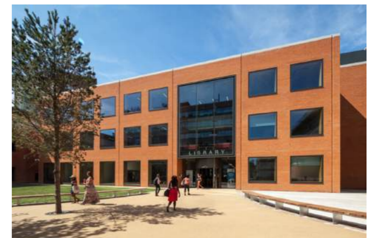
Façade principale mettant l'emphase sur l'entrée et son parvis University of East London Stratford Campus Library Stratford, Londres – Hopkins Architects
