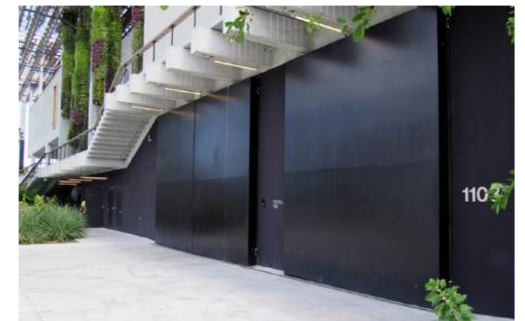
Intégration d'entrées de service Perez Art Museum – Miami, États-Unis – Herzog & de Meuron
