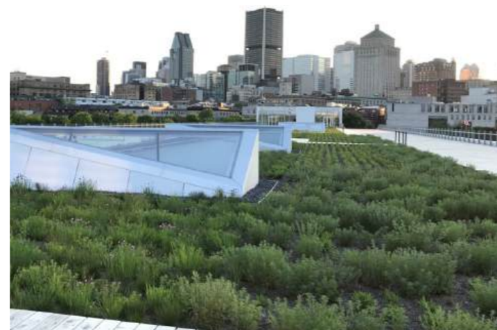
Jardin de toit Grand Quai, Montréal – Provencher_Roy
