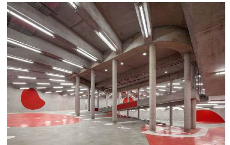
Stationnement souterrain compact, coloré et lumineux Paris, France – Anonyme Studio, Daniel Rousselot
