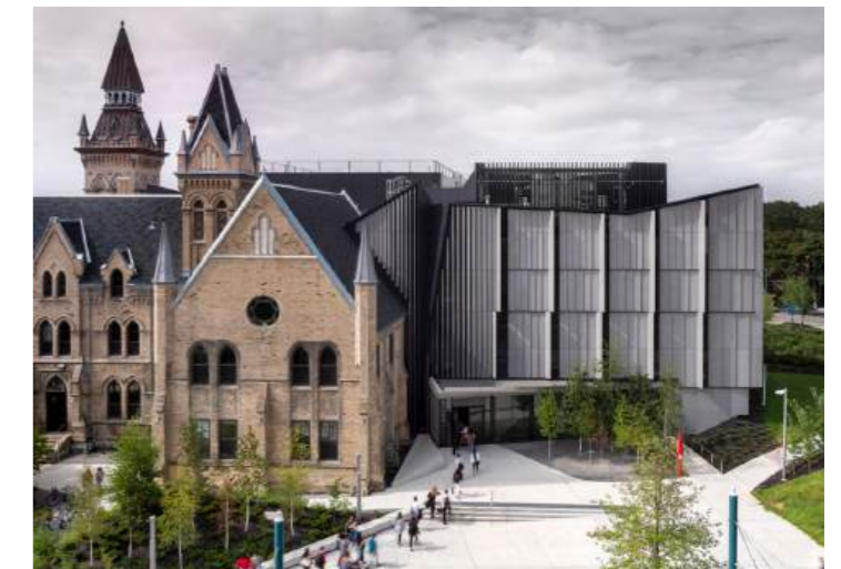
Parvis de bâtiment comme espace de rassemblement Université de Toronto, Canada – Nadaaa, Nic Lehoux
