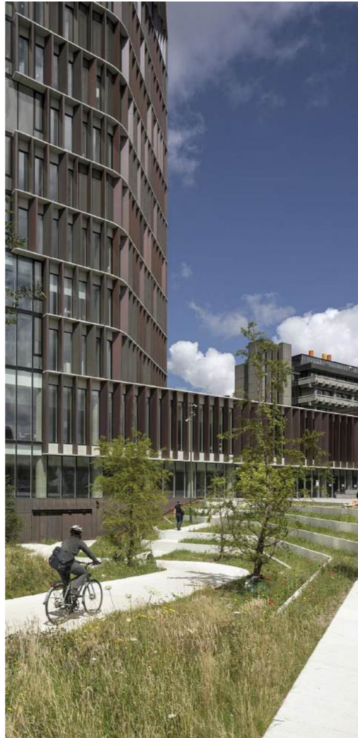
Rampe pour accès cycliste à un stationnement souterrain Université de Copenhague, Danemark – C.F. Møller Architects
