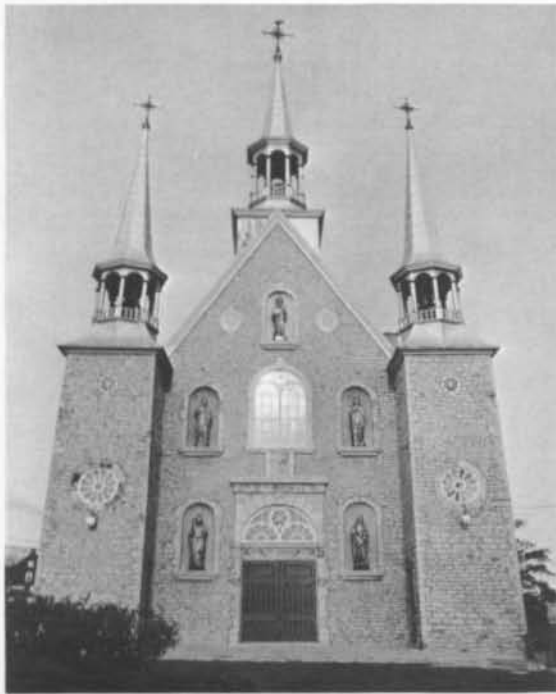
Fig. 1. La façade de l'église de Sainte-Famille (I.O.). (Photo: Léopold Désy).
