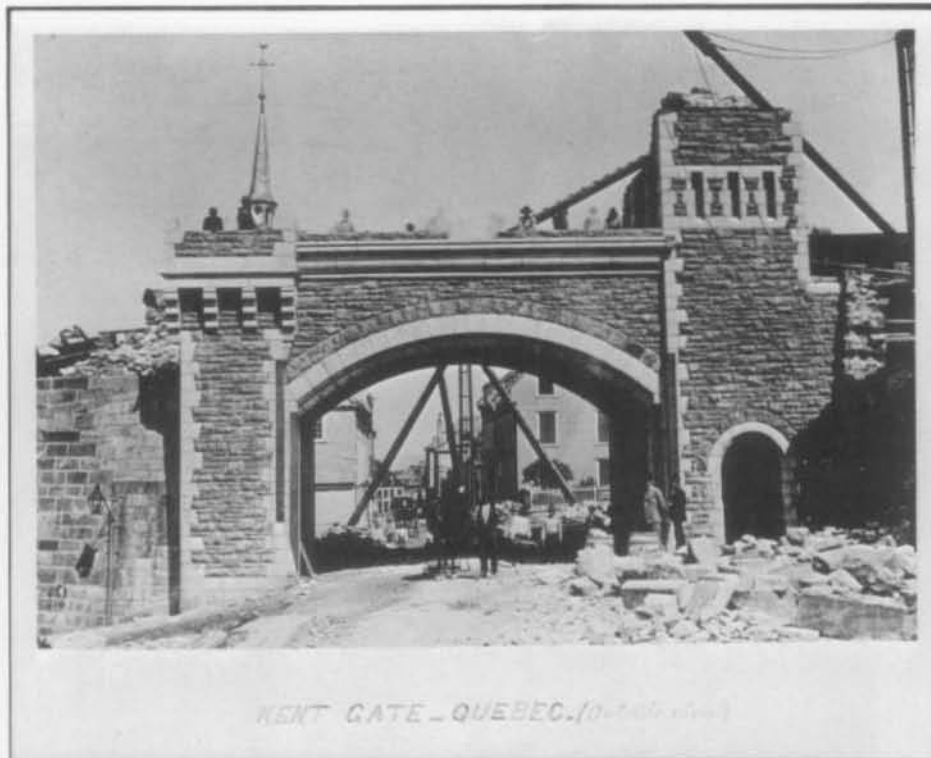
Fig. 14. W. H. Lynn, les travaux de construction des portes Saint-Louis et Kent débutèrent en août 1878. (Photo: Archives Nationales du Québec).
